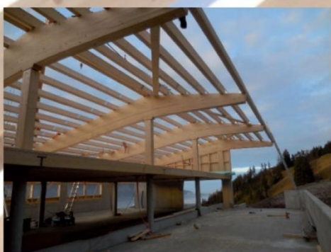
M&T Zimmerei / Elementbau
